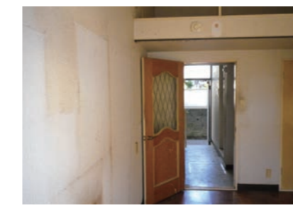
壁のタバコ等のヤニ 通常の使用による損耗を超える⇒ 借主負担
